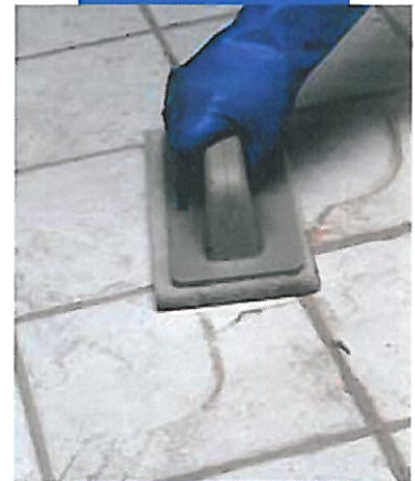
Reinigung des Belages
