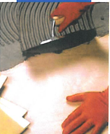
Verlegung von Feinsteinzeug mit Elastorapid
