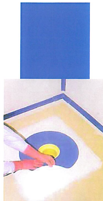
Einarbeiten der Dichtmanschette-Boden in die erste Mapegum WPS-Schicht
