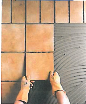
Ansetzen von Steinzeugfliesen im Außenbereich
