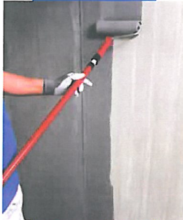
Aufrollen von Eco Prim Grip auf Beton
