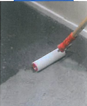
Auftragen von Primer G mit der Rolle
