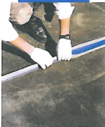
Schlaufenförmiges Einarbeiten von Mapeband
