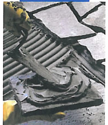
Verlegung von Naturwerksteinen mit unterschiedlicher Plattendicke im Außenbereich
