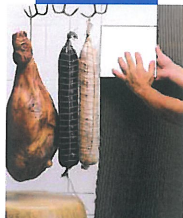
Ausbesserungen in Kühlräumen
