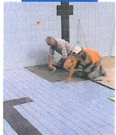
Verlegen von keramischen Fliesen auf Mapelastic in einem Schwimmbecken
