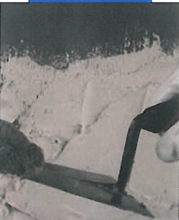
Aufbringen eines Putzes auf Eco Prim Grip
