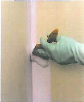
Verarbeitung von Mapegum WPS mittels Pinsel
