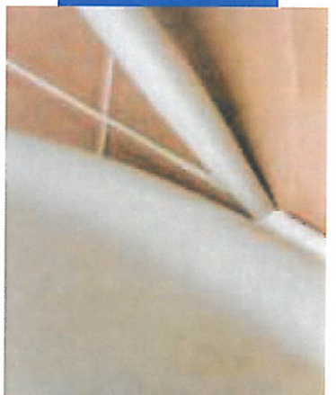
Verfüllen mit Mapesil AC im Sanitärebereich
