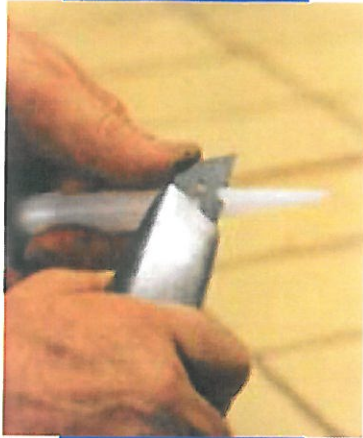
Abschneiden der Kartuschenspitze
