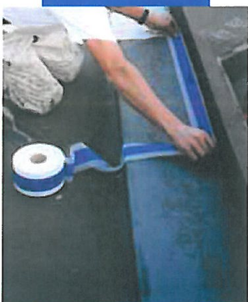
Einarbeiten von Mapeband im Anschlussbereich zur Badewanne
