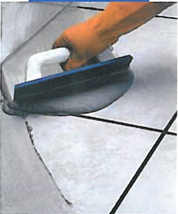
Einfugen eines Keramikbelages mit dem MAPEI-Fugbrett
