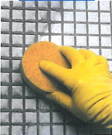
Reinigung mit feuchtem Schwamm
