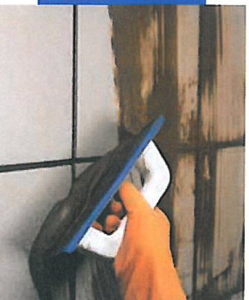
Ausfugen einer Außenwandbekleidung
