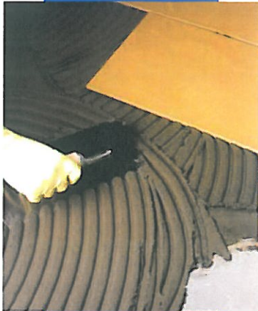
Verarbeiten von Elastorapid mittels Zahnkelle
