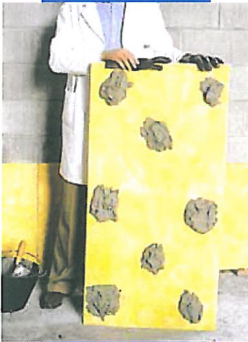
Punktklebung von Dämmplatten auf Mauerwerk
