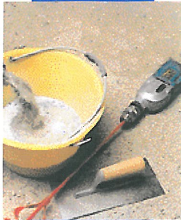
Mischen der Mapelastic-Komponenten
