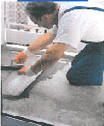
Mapelastic als Balkonabdichtung
