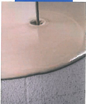
Auftragen von Ultraplano auf getrocknetem Eco Prim Grip
