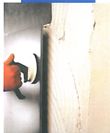
Ansetzen von großformatigem Feinsteinzeug an einer Betonwand
