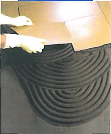
Verlegung von Feinsteinzeug auf einem mit Mapelastic abgedichteten Estrich
