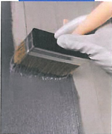
Aufstreichen von Eco Prim Grip auf Beton
