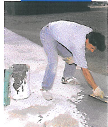
Abdichtung eines Schwimmbeckens mit Mapelastic
