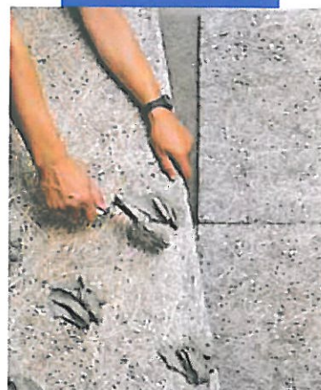
Verlegung von Dämmplatten im Punktklebeverfahren
