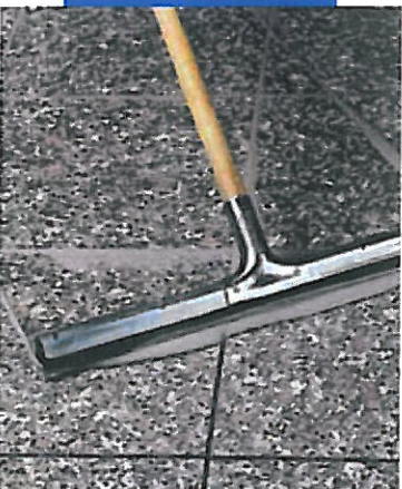
Einfugen einer Bodenfläche mit Keracolor FF Flexfuge
