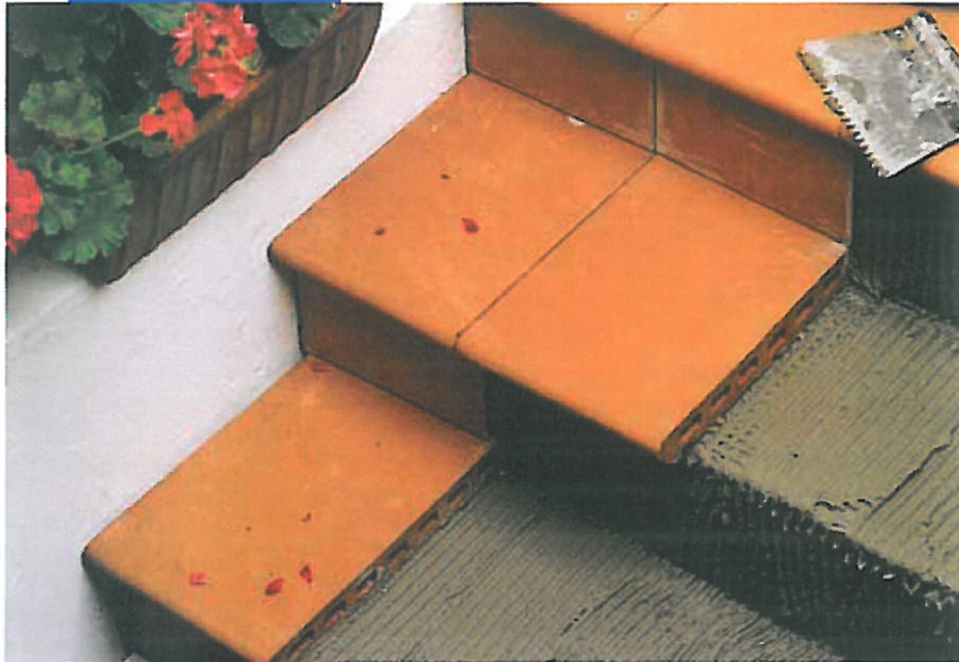
Verlegung von Tonziegelfliesen auf einer Treppenkonstruktion
