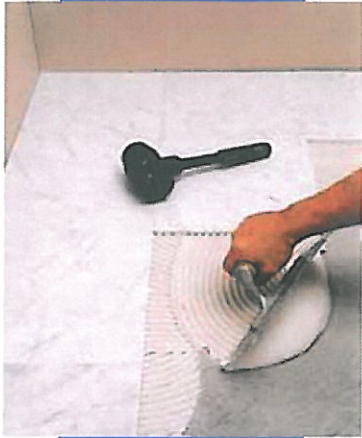
Verlegen von Carrara-Marmor mit Keraquick-weiss
