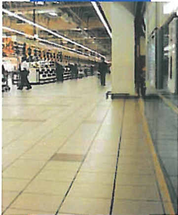
Verlegung mit Keraquick im "Auchan-Supermarkt in Sosnowiec (Polen)
