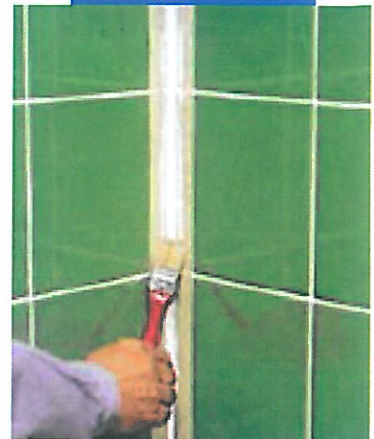
Abglätten der frischen Fuge mit Pinsel und Seifenwasser
