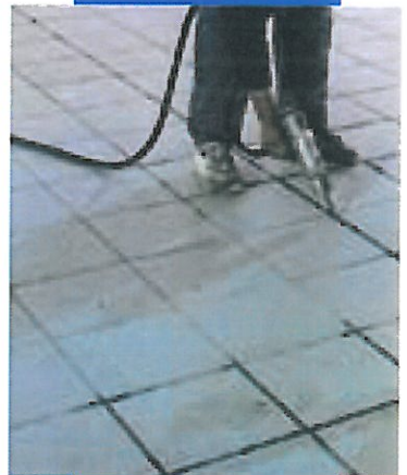
Verfüllen von Dehnungsfugen im Keramikbelag
