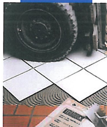
Neuverlegung von Bodenfliesen im Gewerbebereich
