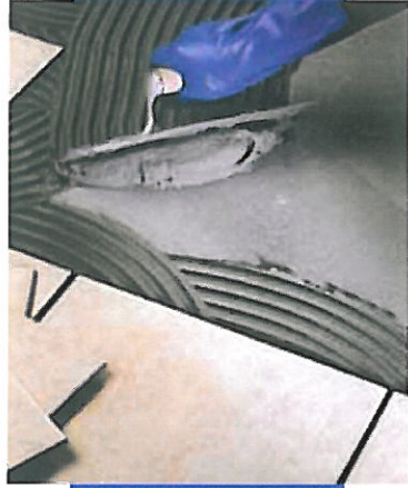
Fliesenverlegung mit Adesilex P9
