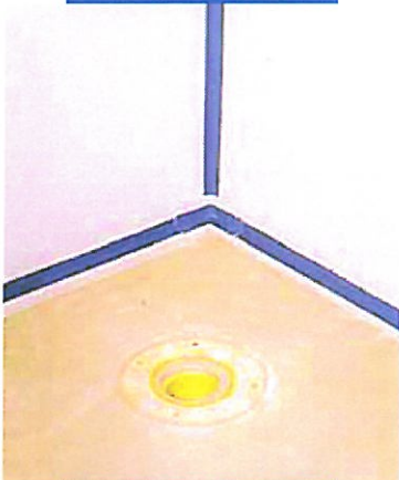
Verbundabdichtung im Badezimmer mit Mapegum WPS und Mapeband
