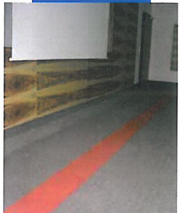
Anwendungsbeispiel für Primer G vor der Spachtelung mit Ultraplan und der Verlegung textiler Beläge mit Rollcoll im Hotel Villa Castellani - Österreich
