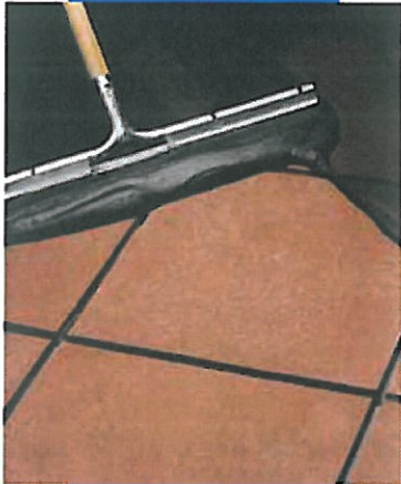
Einschlämmen eines Cotto-Belages mit Keracolor GG Flexfuge
