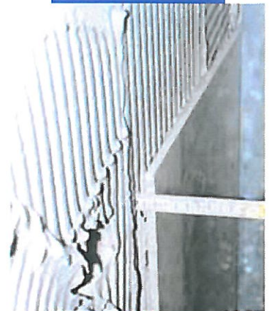
Ansetzen von Feinsteinzeug an der Wand
