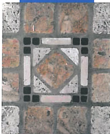
Verfugung eines Natursteinbodens in Antikoptik
