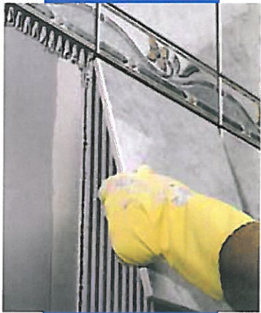
Ansetzen von Fliesen mit Adesilex P9 auf Wandputz
