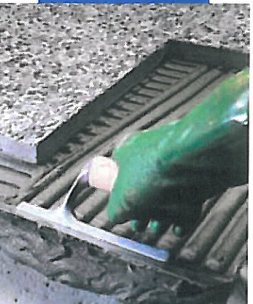
Verlegung von Betonwerksteinen im Außenbereich
