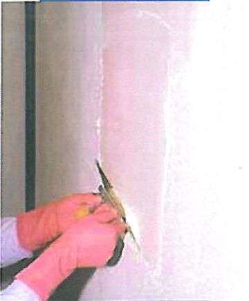
Auftragen des Klebemörtels mittels Zahnkelle auf Mapegum WPS
